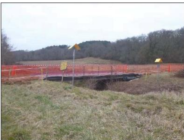
Pont composé d'un assemblage de plusieurs structures métalliques (Source : TERE GA)
