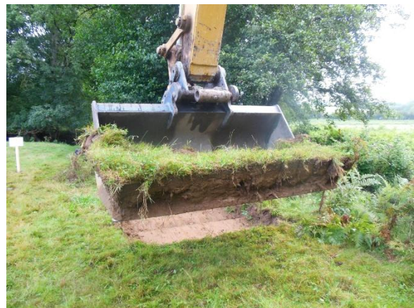
Les plaques de terre seront enlevées avec un godet sans dent (source GERA)
