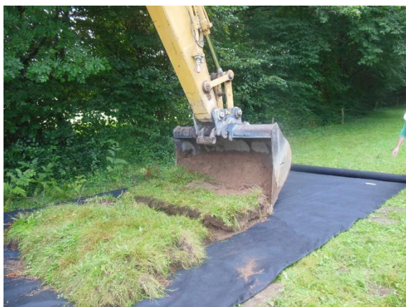
Elles seront ensuite déposées en dehors de la zone des travaux, dans un secteur ombragé. La zone de dépôt temporaire des plaques de terre sera clairement délimitée (Source GERA)
