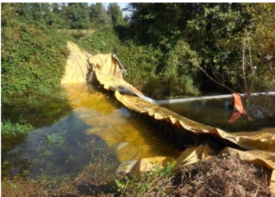
Boudin type « watergate » (à gauche) ou batardeau de big-bags (à droite)
