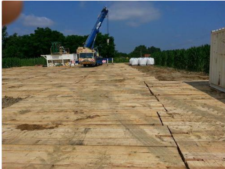
Platelage sur une plateforme
