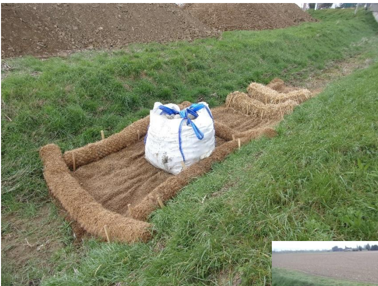
Exemple de système de brise-jet associé à un filtre constitué de rouleaux de toile coco et de bottes de paille.
