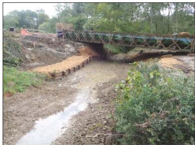
Pont du génie civil/pont Bailey (Source : TERE GA)
