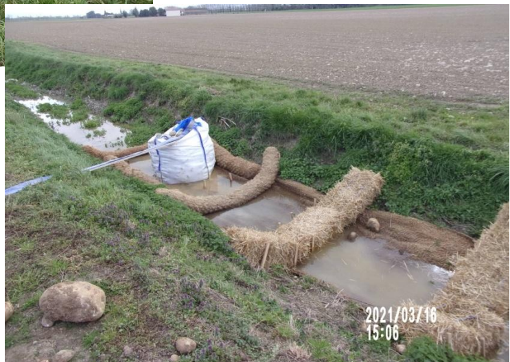
Exemple de système de brise-jet associé à un filtre constitué de rouleaux de toile coco et de bottes de paille.
