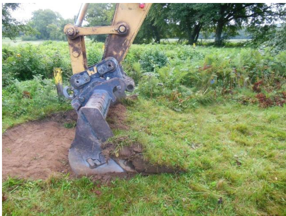
Les plaques de terre seront enlevées avec un godet sans dent (source GERA)
