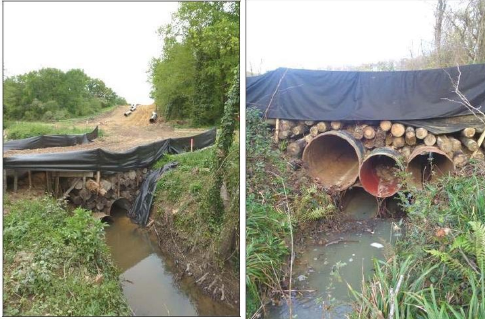
Gaines métalliques recouvertes d'un platelage en rondins de bois (photo : TERÉGA)
